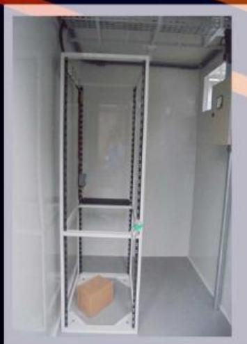
\* Shelter (Abrigo) Modular nas dimensões de 1,40 m (L) x 2,00 m (C) x 2,00 m (Altura Interna), formado por uma estrutura soldada de perfis de aço com proteção contra oxidação através de galvanização a fogo, com paredes e tetos montados através de módulos de "sanduiche" formado por chapas de aço galvanizado e núcleo preenchido de poliuretano expandido.
